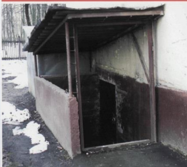
В подвале жилого дома
